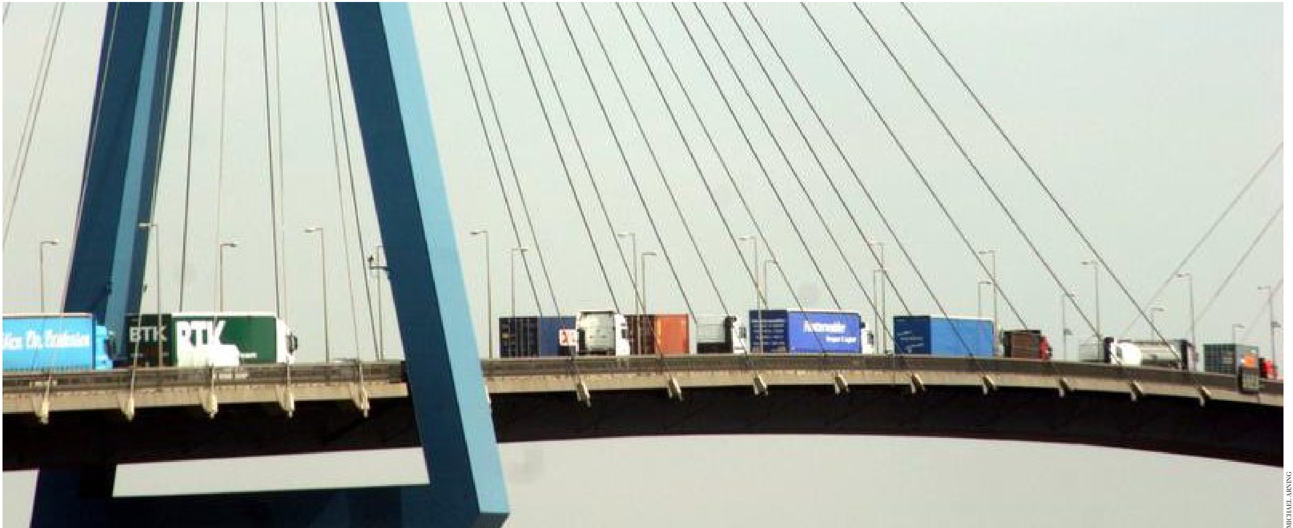
Kein seltenes Bild: Mit Containern beladene Lastwagen stauen sich auf der Köhlbrandbrücke, die noch bis 2017 saniert wird
